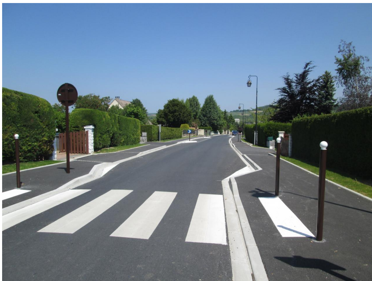
La rue de la mairie toute neuve, sous le soleil !!
